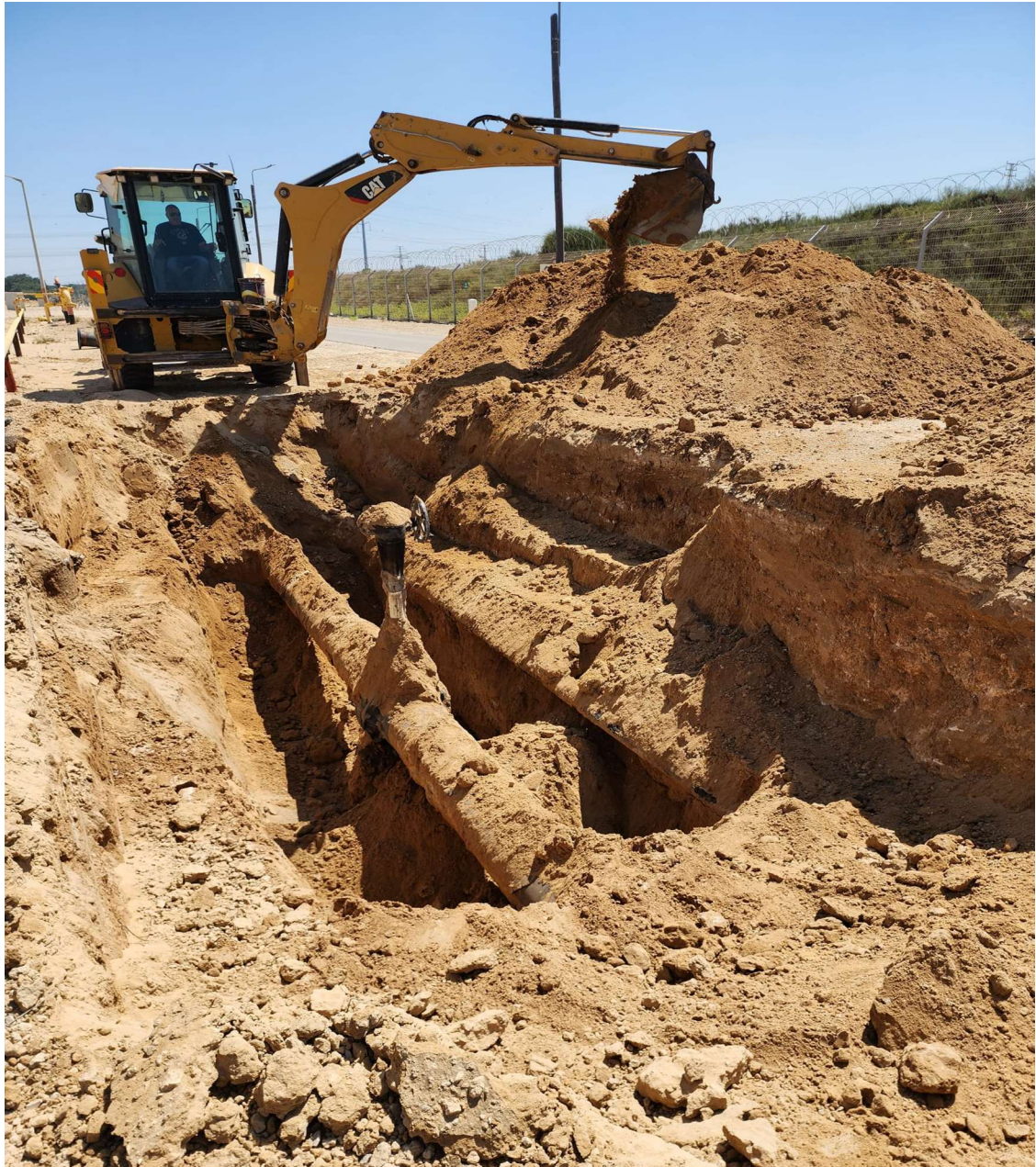
איור 1- חפירת גישוש לאיתור הקו
